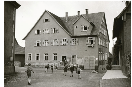
Altes Schulhaus in Nellingen, Klosterhof 6, 1947. Diese Schule stammte ursprünglich von 1826 und wurde mehrfach umgebaut. Hier wurde bis in die 1980er-Jahre unterrichtet.
