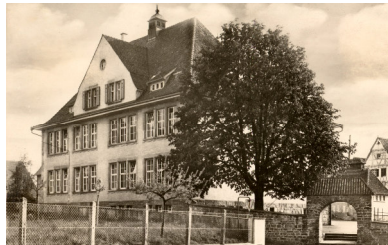
Neue Volksschule im Nellinger Klosterhof, um 1940. Die 1908 erbaute Schule wird bis heute als Klosterhofschule genutzt. Auch sie wurde in der Nachkriegszeit erweitert.
